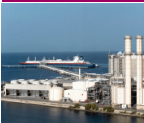
EcoEléctrica, Puerto Rico
